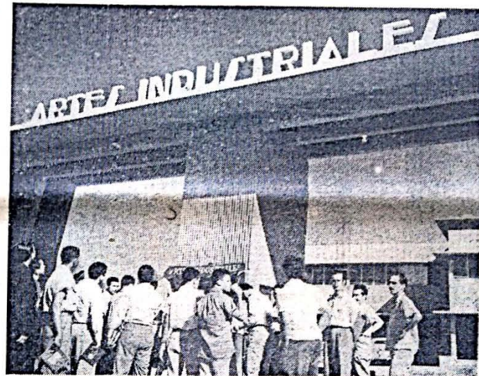
Estudiantes de la Escuela de Artes Industriales de la Universidad de Puerto Rico frente al pórtico del plantel recién construido.
